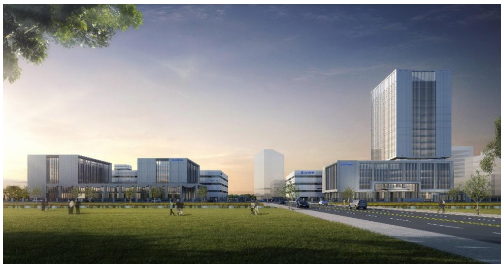
图 10：左侧为公司现有厂房，右侧为公司新厂房
