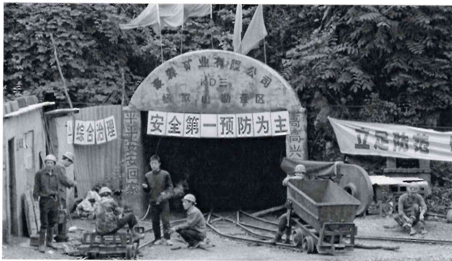
施工中的杨家山勘查区 KD3 坑道 (图2)
